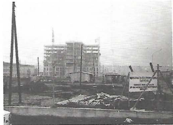
Vista parcial del estado actual de las obras, en la fecha de cubierta de aguas
