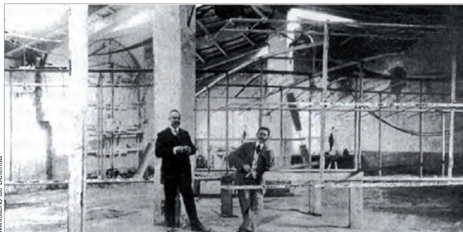
Olivert y Brunet en los talleres Rosell i Vilalta junto a la estructura del aeroplano en construcción.
