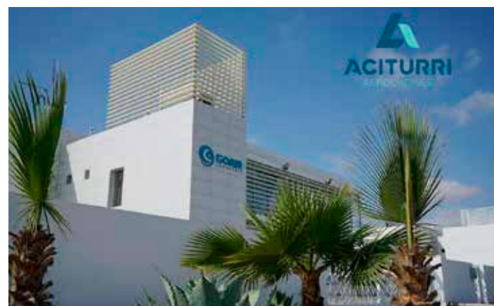
Exteriores de las instalaciones de GOAM Industrie en el MidPark de Casablanca (Marruecos).
