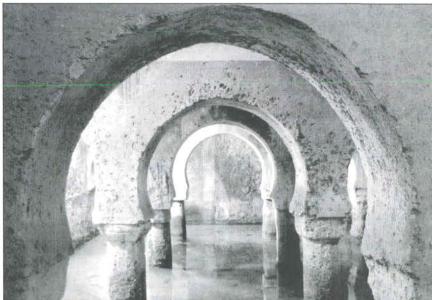
El aljibe árabe de la Casa de las Veletas, único resto conservado del alcázar.
