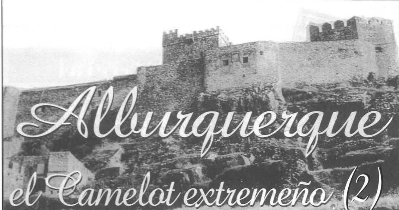
Castillo de Alburquerque. Las obras de ejecución del castillo datan de 1276. Es uno de los bastiones medievales más formidables.
